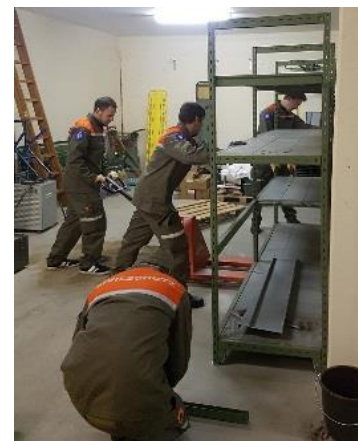
Nachholer bei der Gestellmontage
