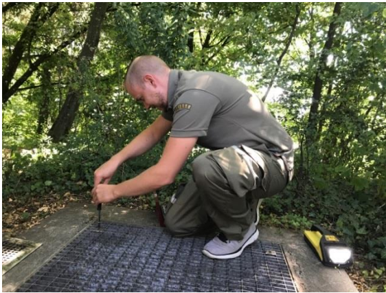
Kontrolle des Aussenschachtes
