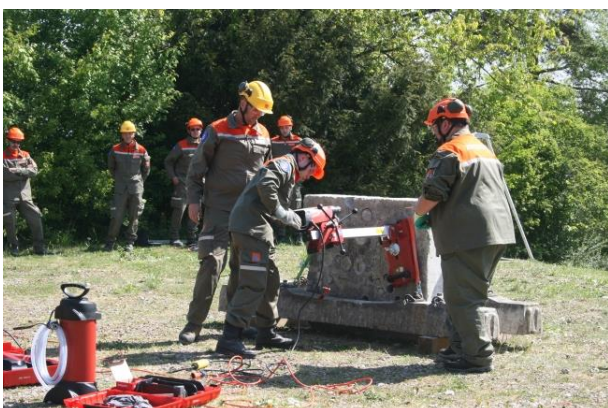
Pioniere mit dem Kernbohrgerät auf der ZSA Eichholz
