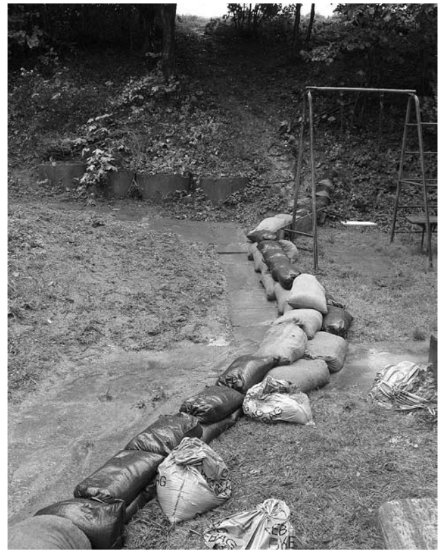
Sandsackabweiskegel: Sandsäcke leiten das Wasser in geordnete Bahnen
