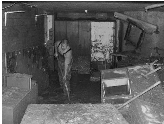
Kellerausräumen: Das grosse Aufräumen nach der Katastrophe
